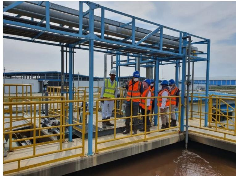
Gambar 4. Pengolahan limbah B3 cair dengan menggunakan metode biologis dengan menambahkan bakteri untuk mengolah limbahnya, salahsatu perusahaan yang berinovasi melakukan pengolahan limbah biologis. PT Dowa Eco System Indonesia
