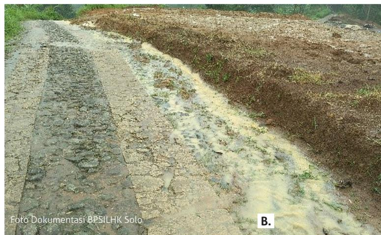
Gambar 2. Kondisi permasalahan DAS (A. Erosi permukaan; B. Erosi pinggir jalan)
